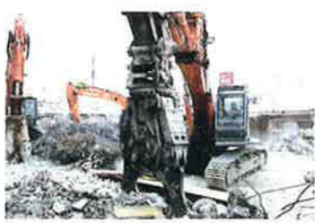
複数の重機で、コンクリートの圧砕やがれきの搬出などをこなす
